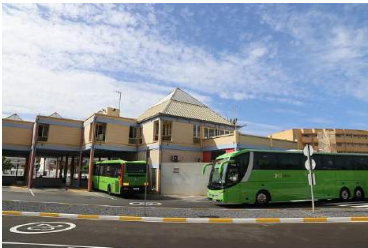
Ilustración 56. Estación de Guaguas de Adeje
