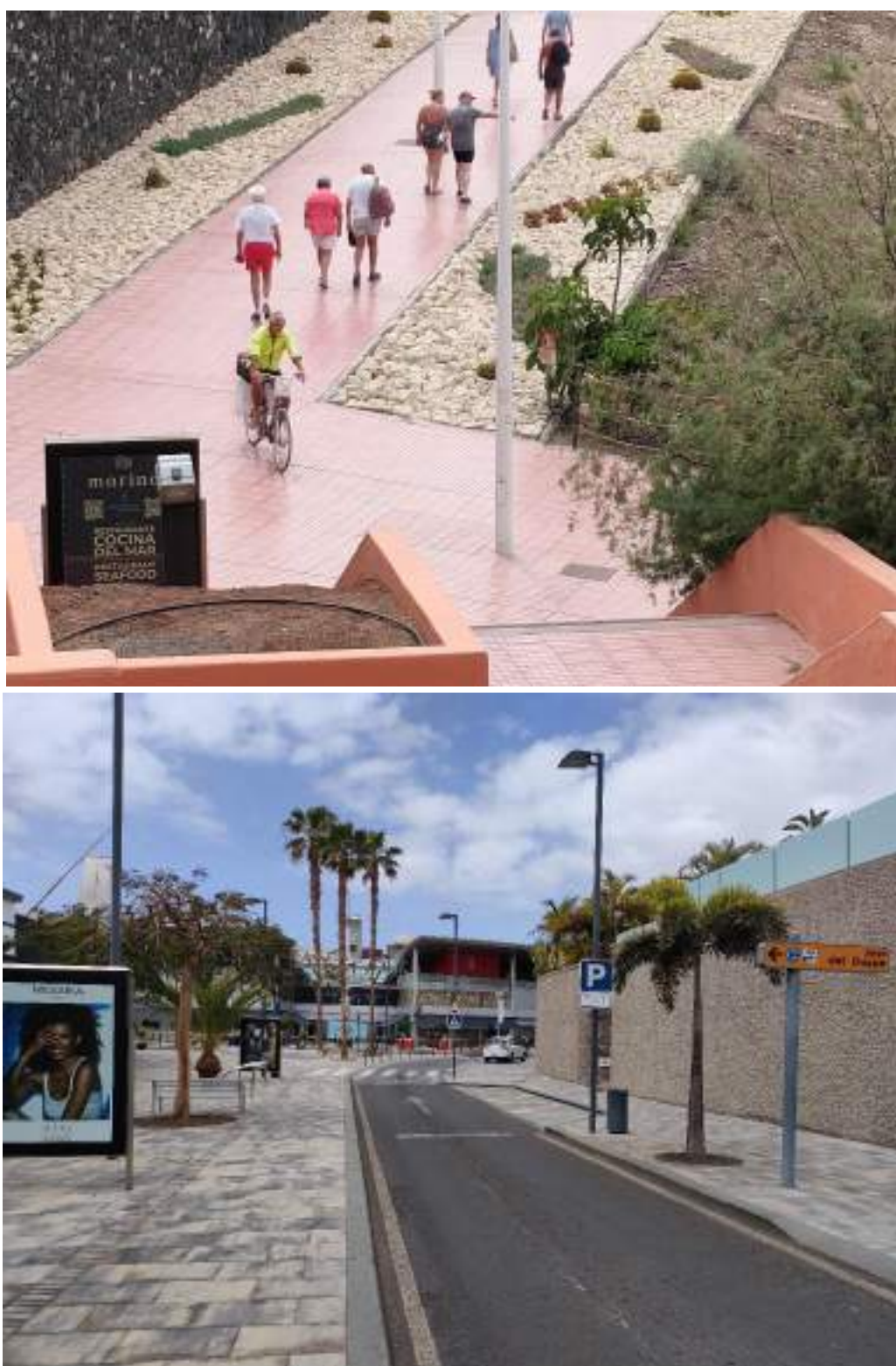
Ilustración 28. Infraestructura peatonal de Costa Adeje
